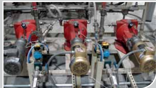
Las 36 bombas LPP-D han aumentado la precisión en las tareas de dosificación en James Hardie.
