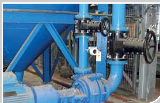
Las válvulas PVEG de Flowrox en reciclaje de metales Sims
