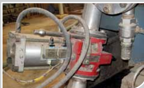
Válvulas de manguito Flowrox en GIIC
